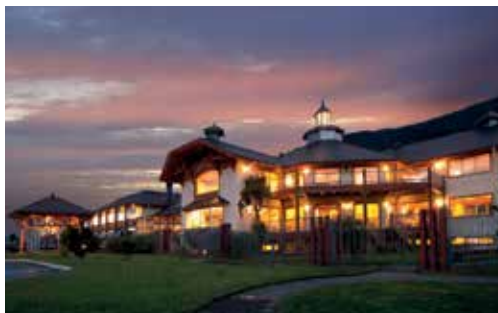
Hotel Loberías del Sur
